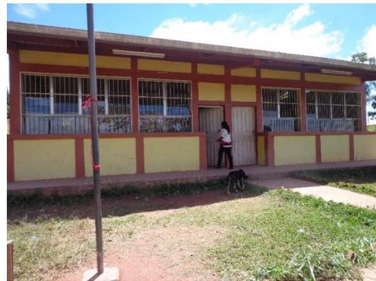
según lo reportado logró desarrollar los siguientes trabajos: Excavaciones y cimentaciones, soleras, castillos, vigas y paredes de bloque, piso de ladrillo tipo terrazo, estructura de techo y lámina de aluzinc, ventanas y balcones tipo PROMINE, pintura de aceite mate, cielo falso de lámina PVC, instalaciones eléctricas, gradas de acceso, aceras perimetrales, canal de aguas lluvias, fosa séptica y pozo de absorción, tanque elevado, muros de contención y relleno, áreas verdes y cunetas.
