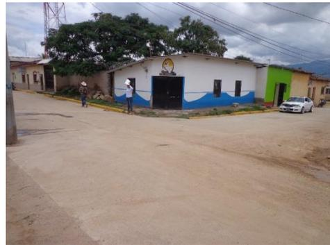
Entre las actividades ejecutadas y verificadas se encuentra el pavimento concreto hidráulico, bordillo de concreto, pintura para bordillo, Tapaderas y casquetes para pozo de inspección y la junta asfáltica en pavimentos.
