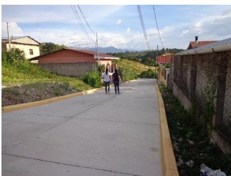
Este proyecto fue ejecutado con fondos de Fideicomiso de Inversiones y Asignaciones FINA y ha beneficiado a 90 habitantes, con una inversión de L. 1, 307,080.46. Consiste en la Construcción de 2 tramos de pavimento de concreto Hidráulico de 685.71 m<sup>2</sup> y 399.68 m<sup>2</sup> respectivamente, este proyecto beneficia a los habitantes y transeúntes del barrio, el otro tramo visitado está ubicado en El Barrio La Cruz, con 6,640 habitantes, sin embargo los beneficiarios directos son
