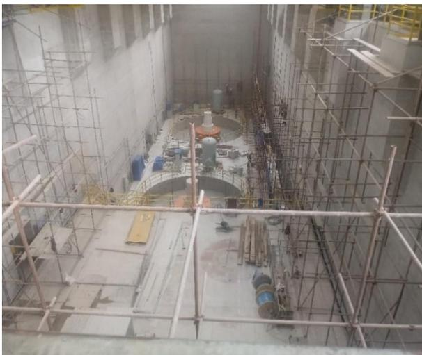
La hidroeléctrica ya tiene instaladas las dos turbinas modelo Kaplan cada una de 52 megavatios lo cual generara 104 megas. Cabe mencionar que las turbinas se ensamblaron en la hidroeléctrica. La producción de energía dependerá de la demanda y la capacidad del río factor de planta de % de energía por las condiciones climáticas.
