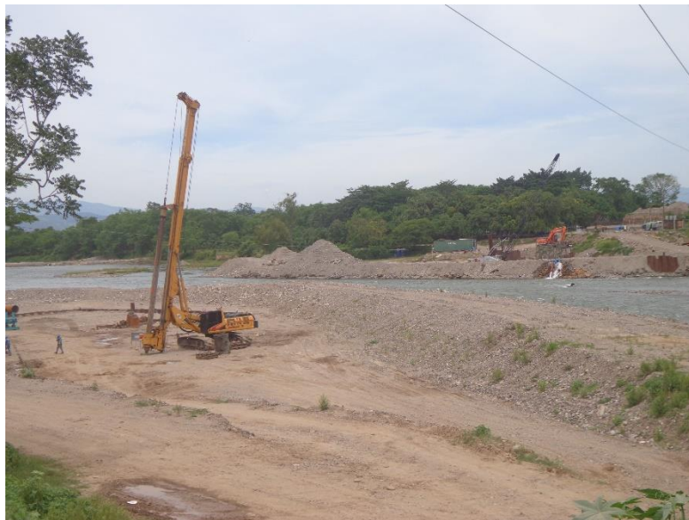
Construcción del nuevo puente Santa Rita
