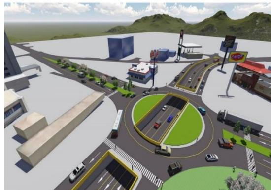
externo de 22.00 metros e interno de 13.00 metros para acoger dos (2) carriles de 4.50 metros cada uno. La longitud total del túnel, desde la entrada hasta la salida, es de 232.50 metros de largo por 15.00 metros de ancho para dos (2) carriles en ambas direcciones, de 3.50 metros de ancho cada uno.
