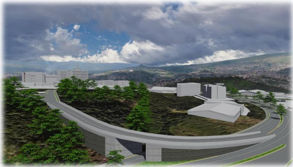
alojo del carril en sentido contrario; este carril se logrará implementando un voladizo sobre el muro de retención existente, colocando columnas de concreto reforzado incrustadas dentro del muro cimentadas sobre zapatas de colindancia que estarán abajo del cauce. La losa en el voladizo será de concreto reforzado, con un barandal y bordillo en la zona exterior del retorno.
