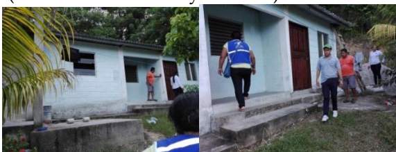
Beneficiarias vivienda del programa vida mejor (casa está destruida y cerrada)
